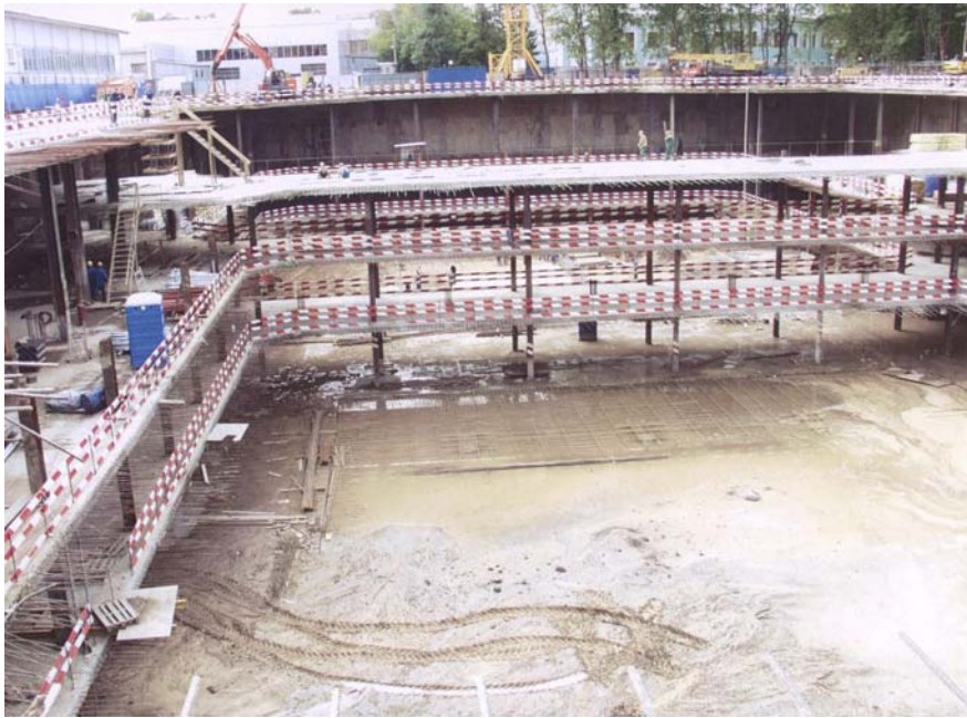
Офисный центр на Ленинградском проспекте
