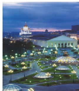
1993 - 97 г. Строительство ТРК "Охотный ряд"
